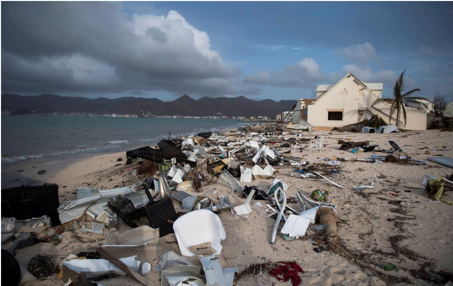
Después de que el huracán Irma destruyera gran parte de San Martín, incluyendo una planta de producción de agua, USAID/OFDA proporcionó servicios de desalinización de agua a través del DoD. Foto de Lionel Chamoiseau, AFP
