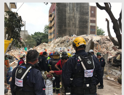
Los especialistas USAR del Departamento de Bomberos del Condado de Los Angeles observan un edificio derrumbado en la Ciudad de México. Foto Cortesía de Sara Rathbun, Departamento de Bomberos del Condado de Los Angeles
