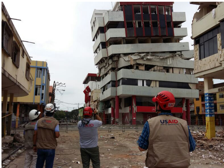
El personal de USAID/OFDA evalúa los daños del terremoto en Portoviejo, Ecuador. Foto de Fabián Arellano, USAID/OFDA
