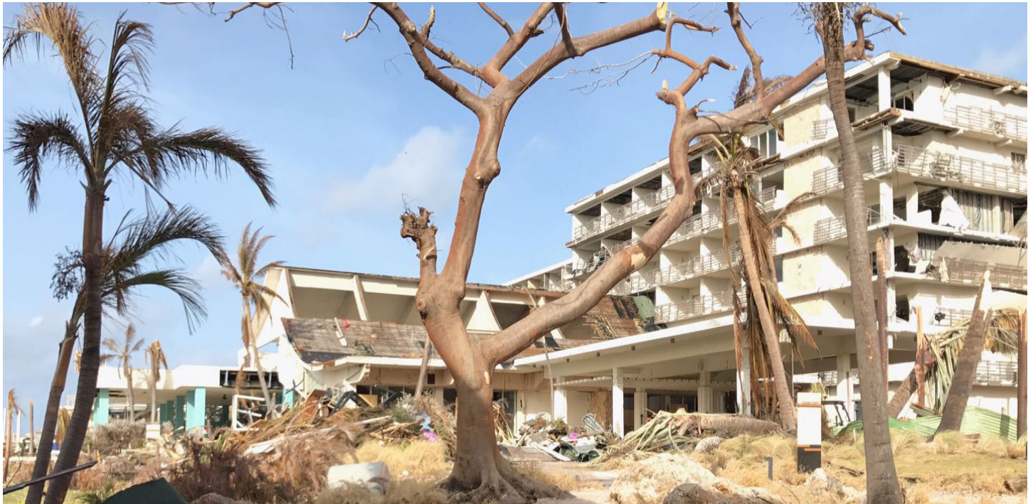
Imagen tras el impacto del huracán Irma en el 2017 en la isla de San Martín. Foto de Ingrid Pederson, USAID/OFDA
