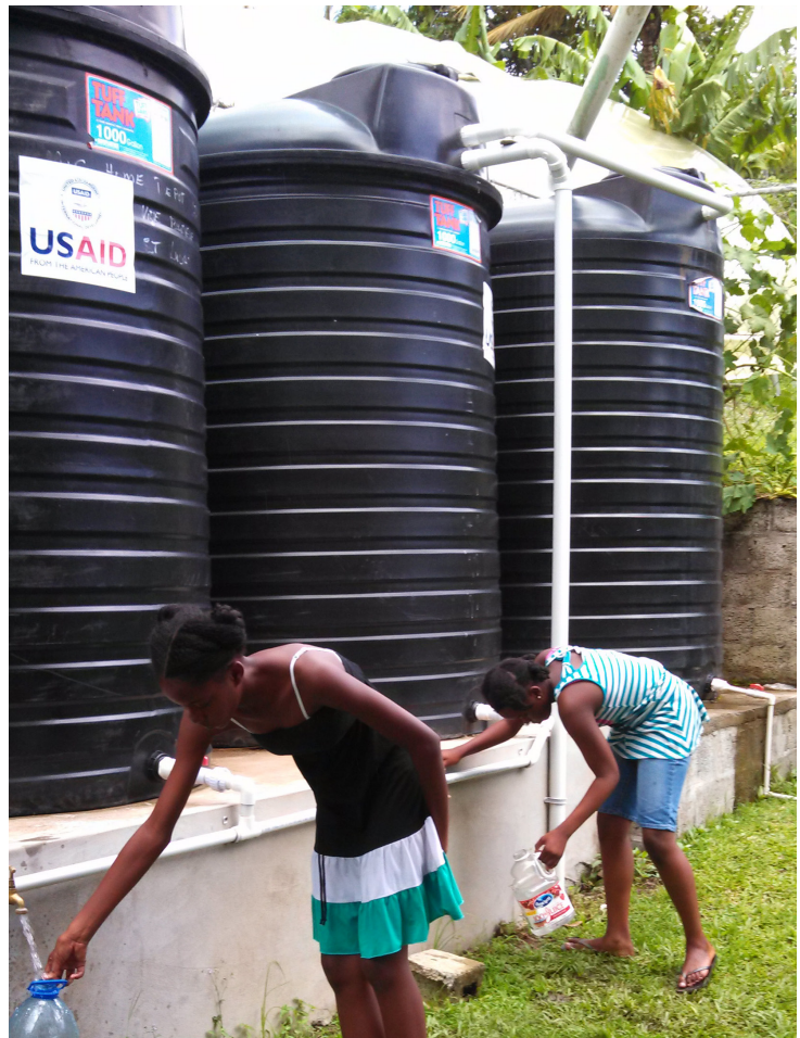
Un pequeño subsidio en 2014 en Santa Lucía instaló sistemas de recolección y almacenamiento de agua de lluvia en seis comunidades vulnerables. Foto de USAID/OFDA
