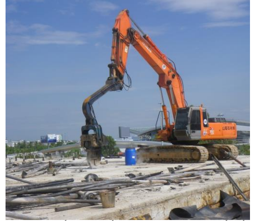
Tháo dỡ thiết bị hệ thống xử lý nhiệt ra khỏi kết cấu (Ảnh: CDM Smith)
