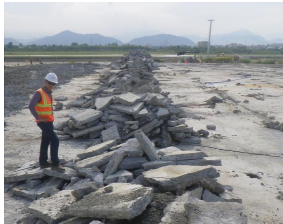
Phá vỡ nắp bê tông kết cấu xử lý nhiệt (Ảnh: CDM Smith)
