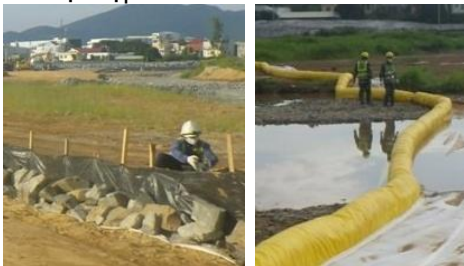
Kiểm soát xói lở – rào chắn bùn (trái) và bờ bao ngăn nước đục (phải) (Ảnh: CDM)
