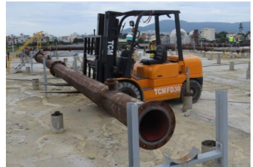
Tháo dỡ đường ống dẫn hơi nước từ kết cấu xử lý Giai đoạn 1 (Ảnh: CDM Smith)
