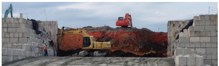
Tháo dỡ đất và bùn đã qua xử lý Giai đoạn 1 từ vách phía nam của kết cấu xử lý nhiệt. (Ảnh: USAID)
