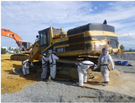
Làm sạch thiết bị trước khi rời khỏi công trường (Ảnh: CDM Smith)
