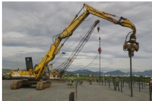
Đặt giếng truyền nhiệt vào móng xử lý (Ảnh: CDM Smith)
