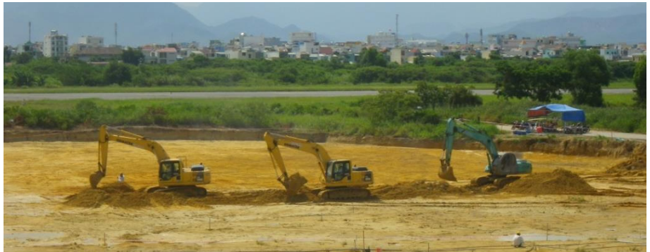
Đào xúc thêm để mang đi xử lý đất bị nhiễm bẩn ở Khu Lưu trữ (Ảnh: CDM Smith)
